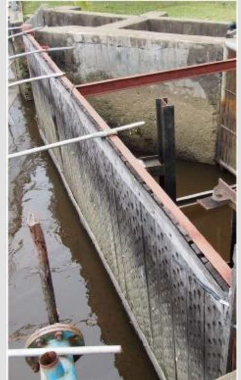
Instalasi Pengolahan Air Kota Pontianak, Kalimantan Barat
