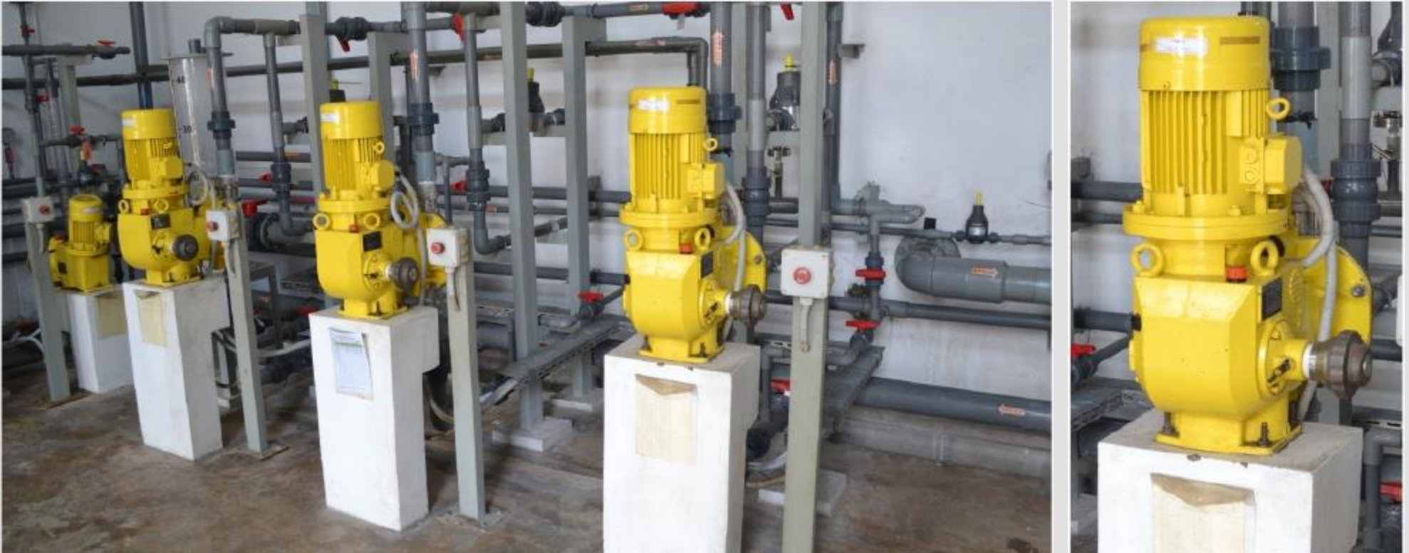
Instalasi Pengolahan Air (2010) Kabupaten Tangerang, Banten
