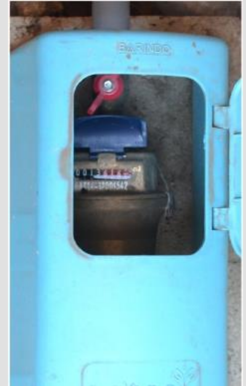
Sambungan Rumah (2011) Kabupaten Tangerang, Banten
