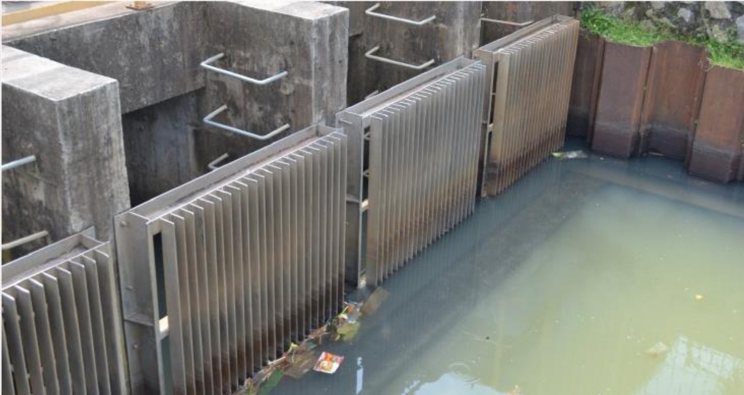
Instalasi Pengolahan Air (2010) Kabupaten Tangerang, Banten
